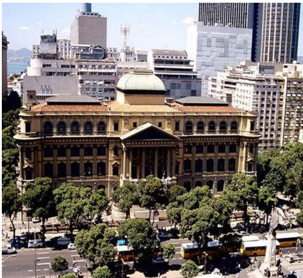
Figura 10: prédio-sede da Fundação Biblioteca Nacional, guardião do maior acervo de obras raras da América Latina
